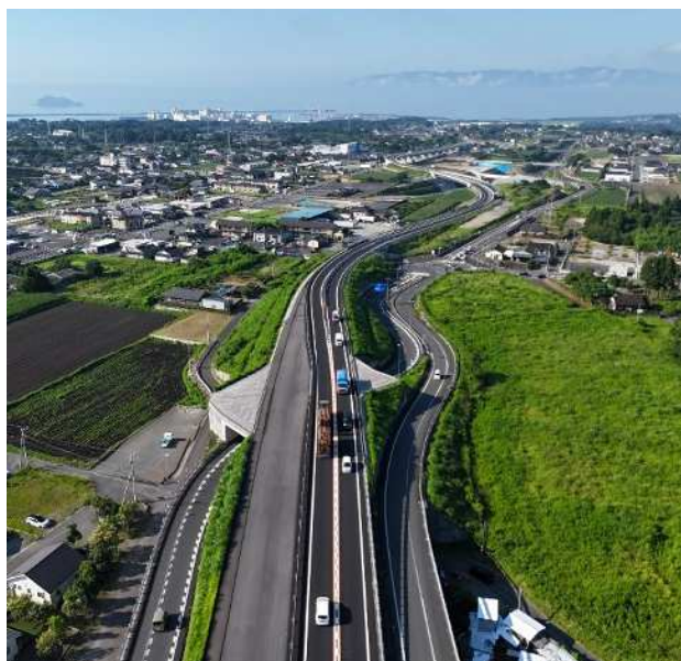
■人やモノの交流を支える陸海空の交通ネットワークの形成 高規格道路の整備（写真：都城志布志道路 志布志道路）
