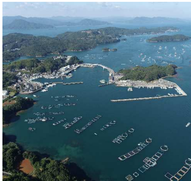
■「農林水産業の「稼ぐ力」の向上に資する生産基盤づくり」 を図る事業 漁港の整備（写真：薄井漁港）
