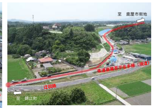
(県道鹿屋吾平佐多線との交差部)
