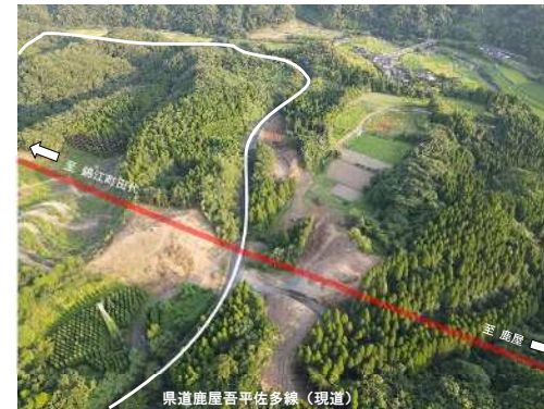
(県道鹿屋吾平佐多線との交差部)
