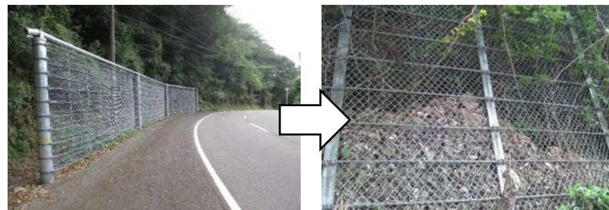
落石防護柵が崩土を捕捉し、通行止めを阻止
