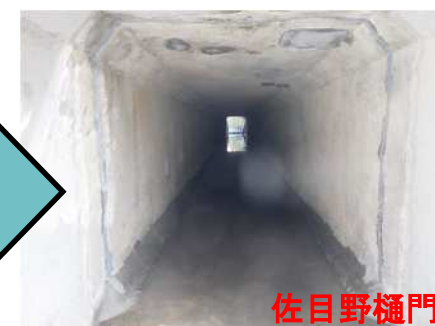
樋管内部のコンクリート補修
