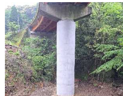
【橋脚の巻立て】
