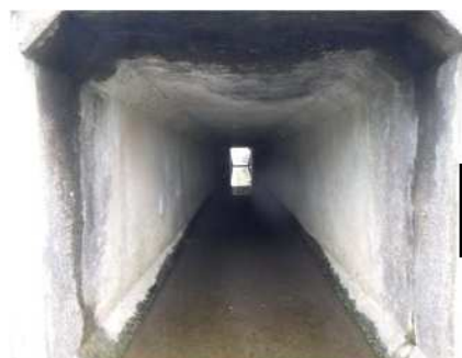
樋管内部のコンクリート補修
