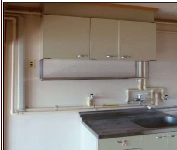
台所の配管改修後の状況
