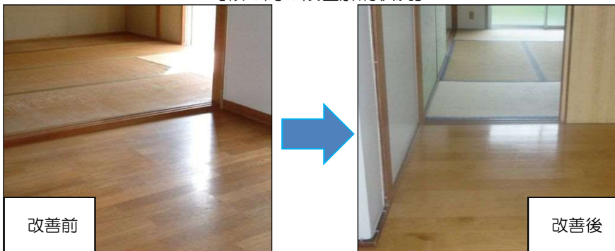
【板の間の段差解消状況】
