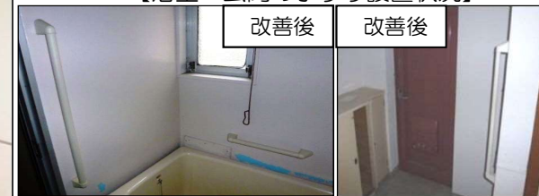
【浴室・玄関の手すり設置状況】
