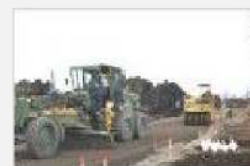
丁張に合わせて施工
