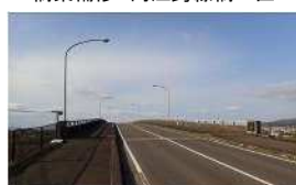
橋梁補修 向江跨線橋工区
