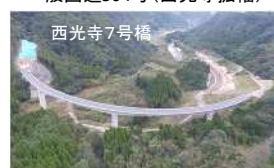
一般国道504号(西光寺拡幅)
