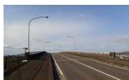
橋梁補修 向江跨線橋工区
