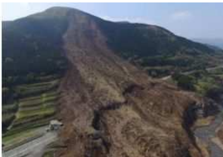
自然法面の崩落
