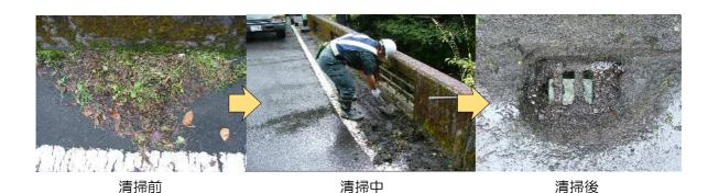
写真-日常点検時の清掃状況(排水装置土砂詰り)
