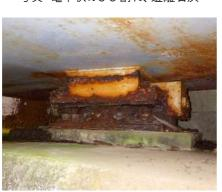
写真-支承部の腐食
