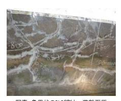
写真-亀甲状のひび割れ、遊離石灰
