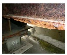
写真-主桁の腐食
