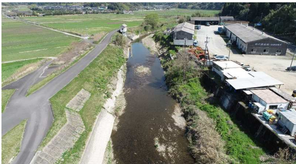
令和3年6月27日～7月11日の梅雨前線豪雨による被災直後 樋渡川（薩摩川内市）
