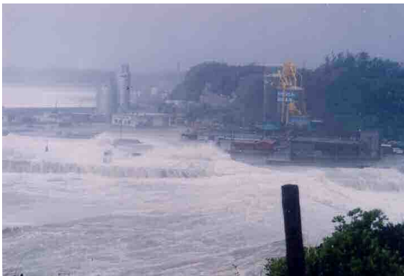
台風第13号(H5.9)による越波 平土野地区(徳之島)
