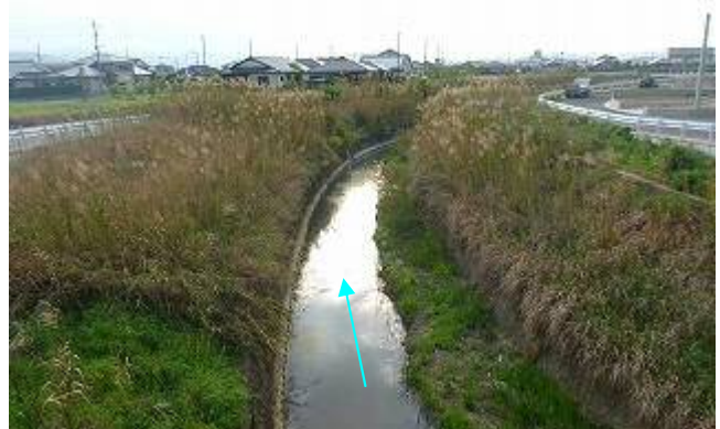
写真 2-4 三堂橋から下流を望む
