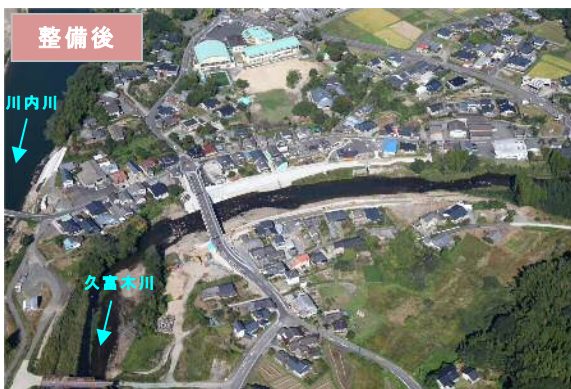
写真 1-4 久富木川における整備状況
