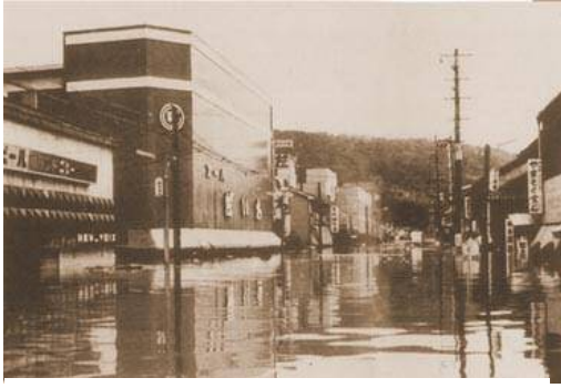
写真 1-8 市街地浸水状況 (薩摩川内市)
