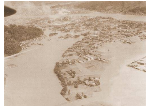
写真 1-10 支川高城川の氾濫状況 (薩摩川内市)
