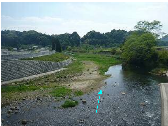
写真 2-11 東橋より下流望む (整備後)
