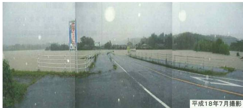
写真 2-7 浸水状況 (H18.7: 夜星川橋)
