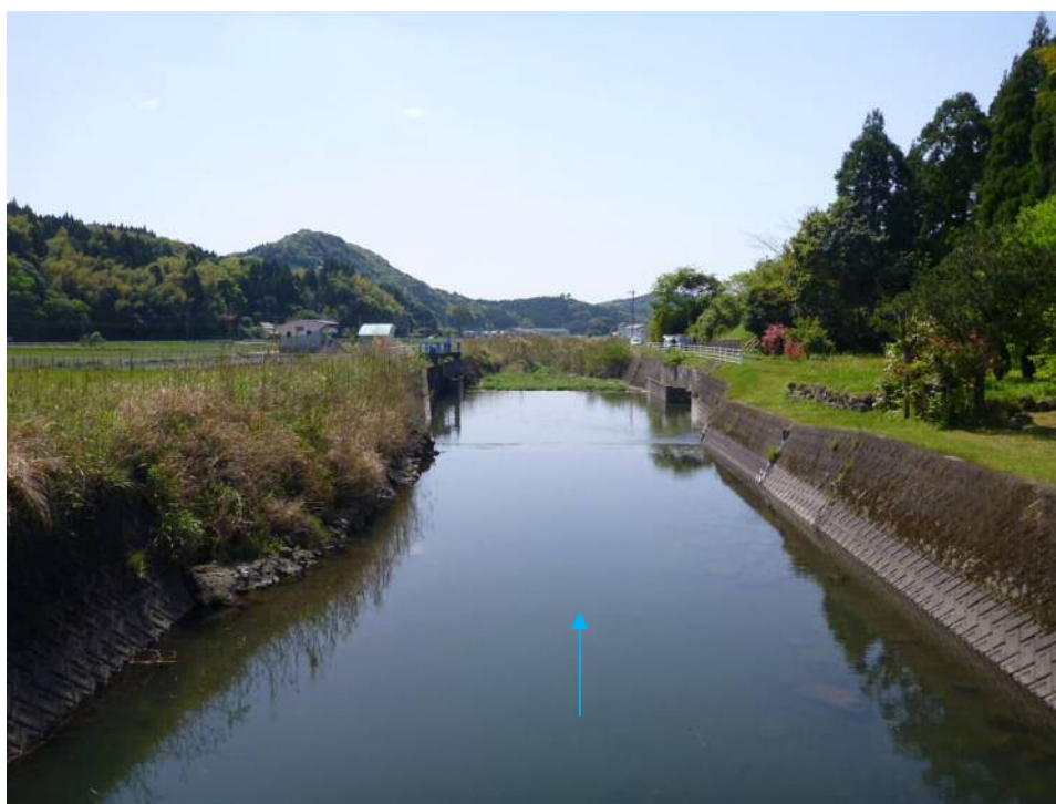
写真 2-13 坂元頭首工を上流から望む（麦之浦川）
