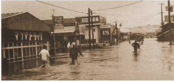
写真 1-11 上川内地区浸水状況（薩摩川内市）
