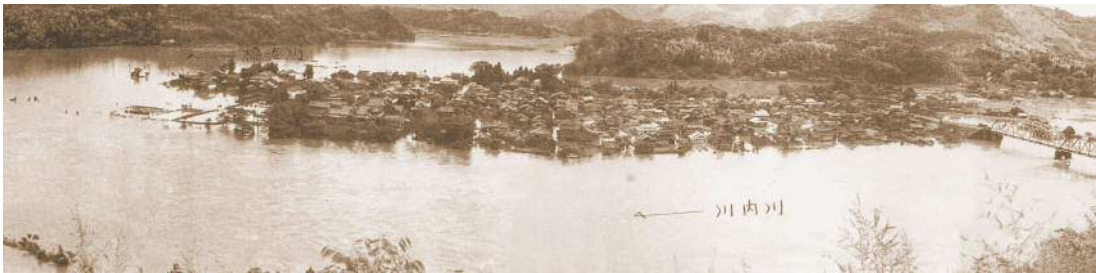
写真 1-6 東郷地区浸水状況（薩摩川内市）
