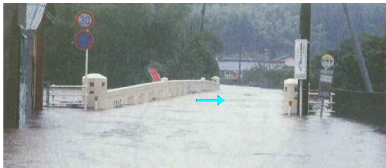
写真 2-10 浸水状況 (H18.7: 東橋)
