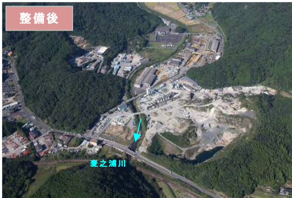
写真 1-2 麦之浦川における整備状況
