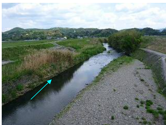
写真 2-8 夜星川橋より下流望む (整備後)
