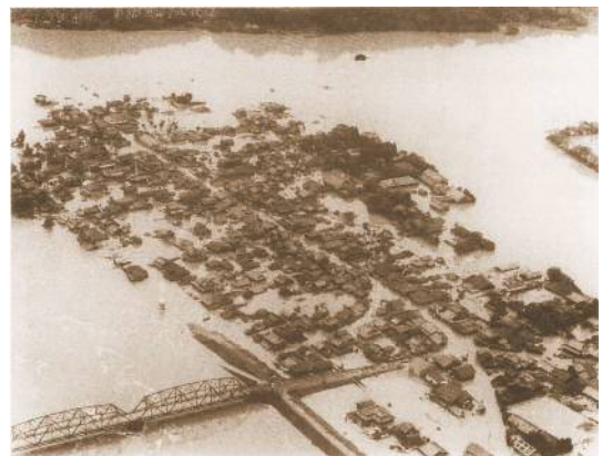
写真 1-7 東郷地区浸水状況 （薩摩川内市）
