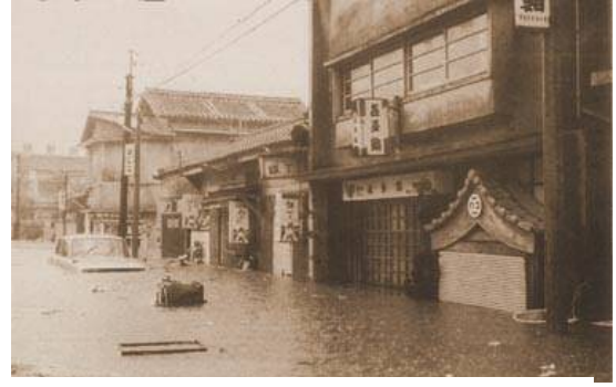
写真 1-9 市街地浸水状況 (薩摩川内市)
