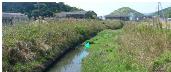
写真 2-1 王子田橋から下流を望む
