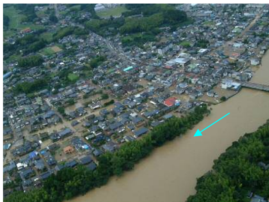
写真 1-17 虎居地区浸水状況 (さつま町)
