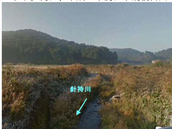
写真 2-4 針持川未整備箇所(高野橋上流)
