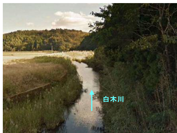
写真 2-6 白木川未整備箇所(観音橋下流)
