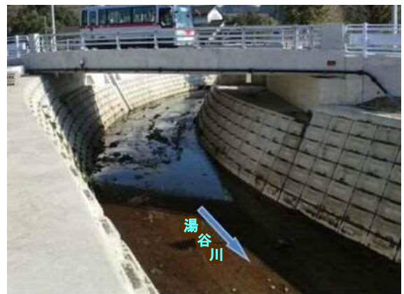
写真 2-11 湯谷川整備済箇所(湯谷橋)
