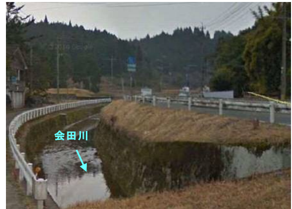
写真 2-10 会田川未整備箇所 (主要地方道 55 号線上流)
