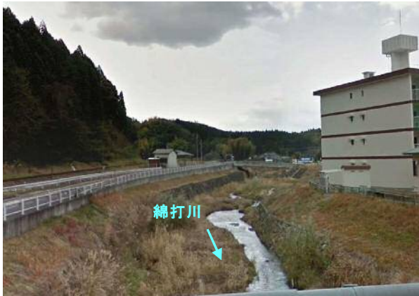
写真 2-9 綿打川整備済箇所(坂元下橋上流)
