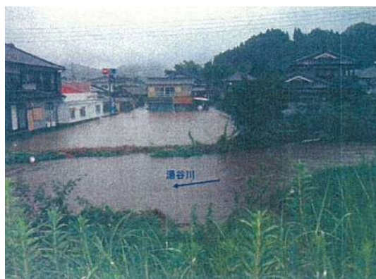
写真 2-2 湯谷川浸水状況 (H18.7洪水)
