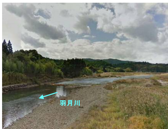
写真 2-5 羽月川未整備箇所(淵辺橋上流)
