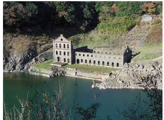
写真 2-21 曾木発電所遺構（国登録） (写真：伊佐市 HP)
