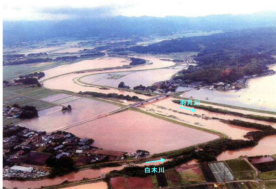
写真 2-3 白木川浸水状況 (H18.7洪水)
