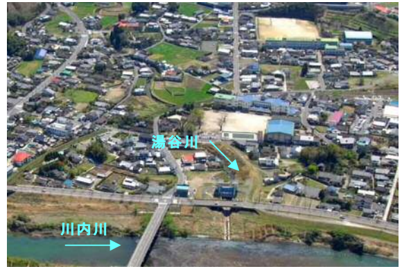
写真 1-4 湯谷川における整備状況 (H11～15年度直轄床上浸水対策特別緊急事業)
