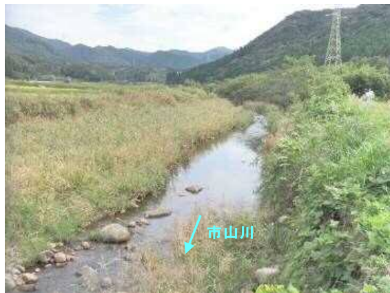
写真 2-7 市山川未整備箇所(6k000 付近)
