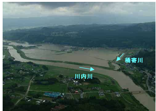
写真 1-19 川添川地区浸水状況 (湧水町)
