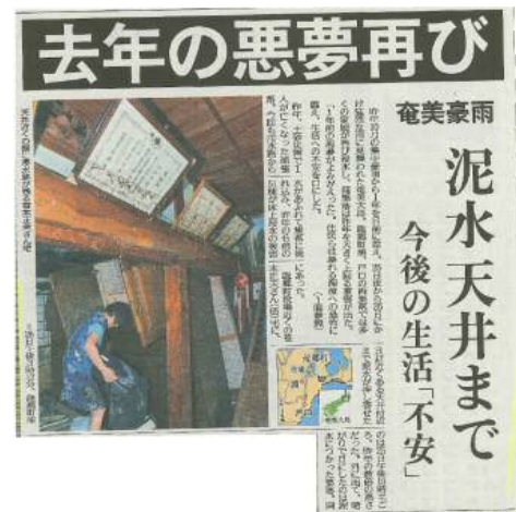
写真 2-2 H23.9 洪水による浸水被害状況 (H23.9.27 南日本新聞)
