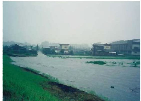
写真 1-10 高山川左岸 2k000 付近 堤内地浸水状況
