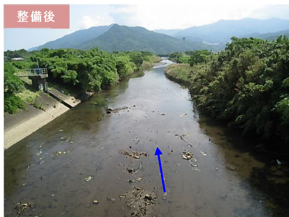
写真 1-1 塩入川の河川整備状況 〔弁天橋(1k750)下流〕
