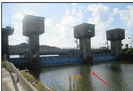
草道川現況河道（臼江水門(0/000)の状況）
