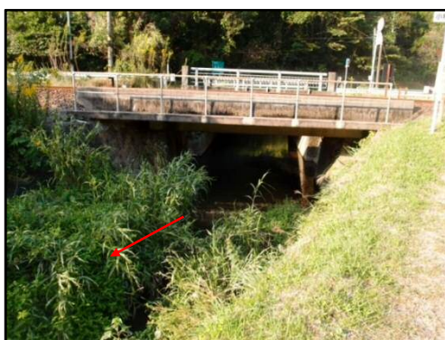
草道川現況河道（JR橋(2/300)の状況）
