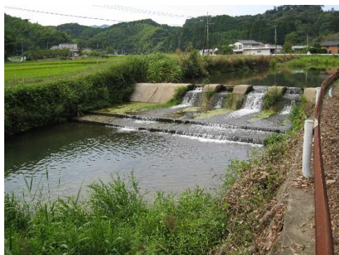
【田神丸頭首工】
