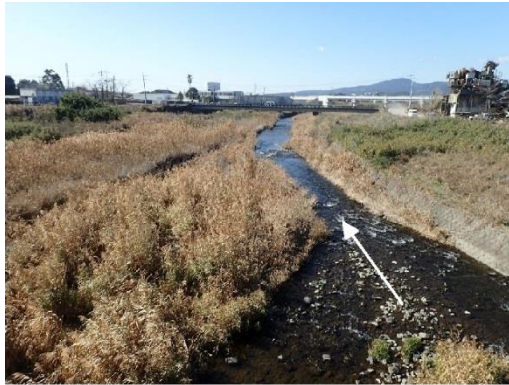
写真 1-1 高尾野川の状況 (5k000 付近)
