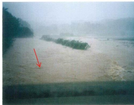
【野田川 8/770 付近中田橋上流左岸の溢水状況】
