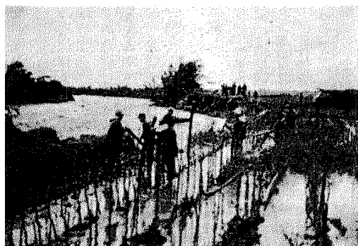
【青木橋下流の堤防決壊状況】：高尾野町誌より
