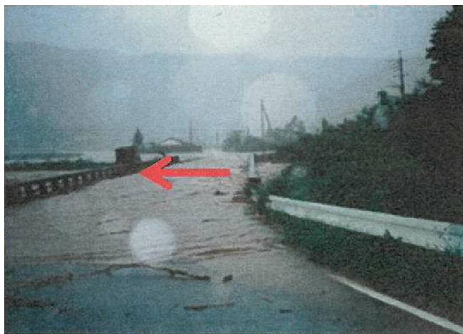
写真 1-1 平成 9 年洪水 北之口橋の状況写真
