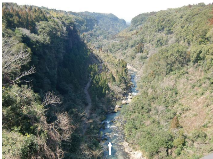
写真 2-3 瀧見大橋より下流をのぞむ
