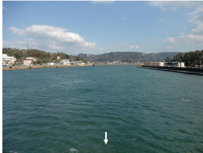
写真 2-1 根占大橋より上流をのぞむ
