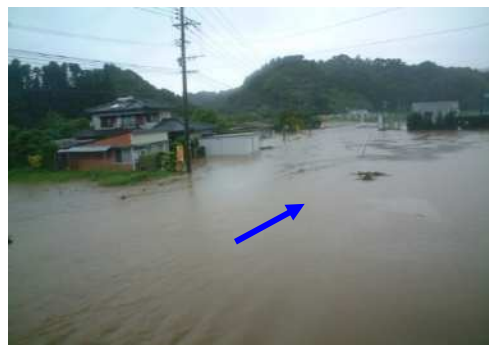
写真 1-2 平成 19 年 6 月 花渡川 (金山橋付近)
