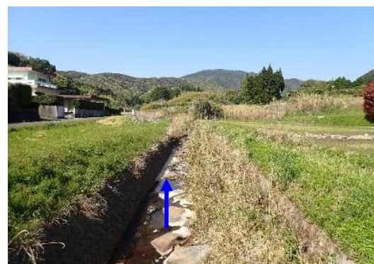
写真 2-6 現況河川の状況（金山川） 第二田布川橋より下流
