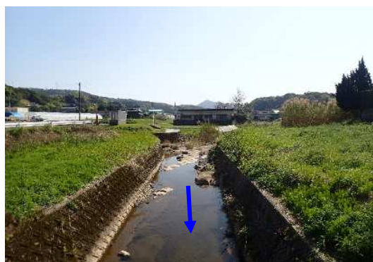
写真 2-5 現況河川の状況（金山川） 金山橋より上流
