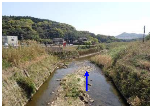
写真 2-2 現況河川の状況（花渡川） 滑川橋より下流
