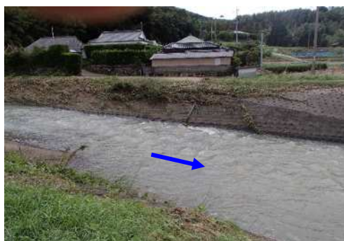
写真 1-3 平成 28 年 9 月 中洲川 (下園橋付近)
