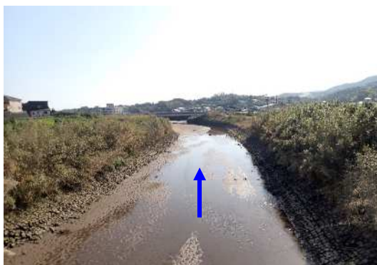
写真 2-3 現況河川の状況（中洲川） 宝寿庵橋より下流
