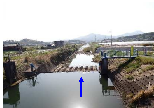
写真 2-4 現況河川の状況（中洲川） 下園橋より下流
