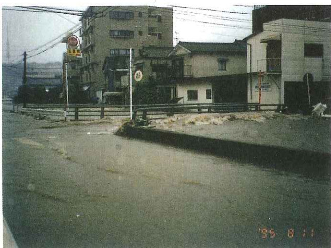
■下流唐湊橋付近左岸
