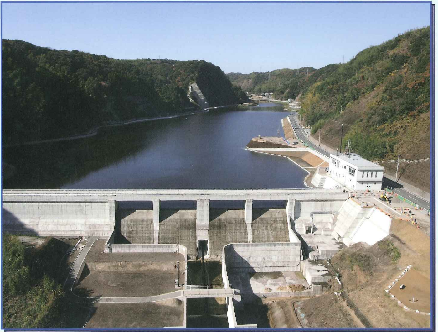
試験湛水最高水位(平成24年12月撮影)
