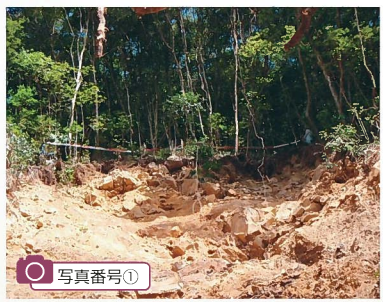
山腹崩壊状況
