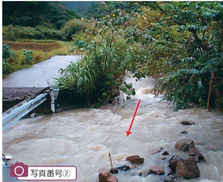
国道BOX埋塞に伴う氾濫状況
