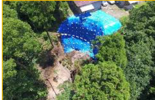
7/6 志布志市有明町樽野地区(がけ崩れ) 施設災(砂防)
