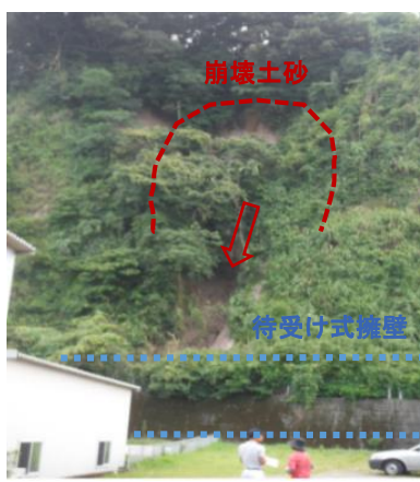
砂防関係施設が崩壊土砂を捕捉 (鹿児島市坂之上地区)
