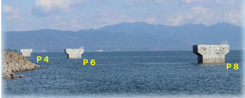
施工状況(新栄町から)
