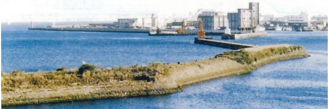
写真 2-4 昭和 57 年頃の防波堤（新波止, 遮断防波堤, 一丁台場）と赤灯台（旧北防波堤灯台）
