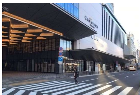
写真 6-4 壁面後退・セミパブリック空間の例
