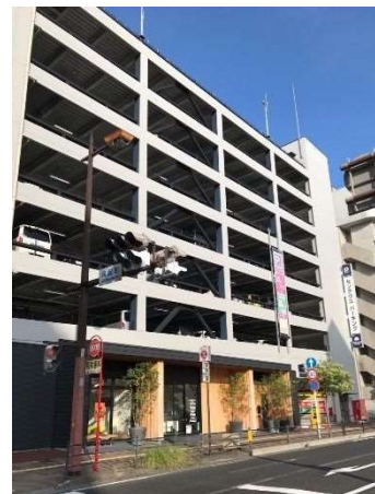
写真 6-14 1階部分を工夫した駐車場の例
