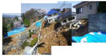
(d)液状化による側方流動の事例
