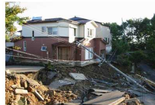
新潟県中越地震の被害
