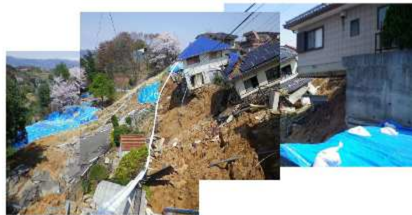
(d)液状化による側方流動の事例
