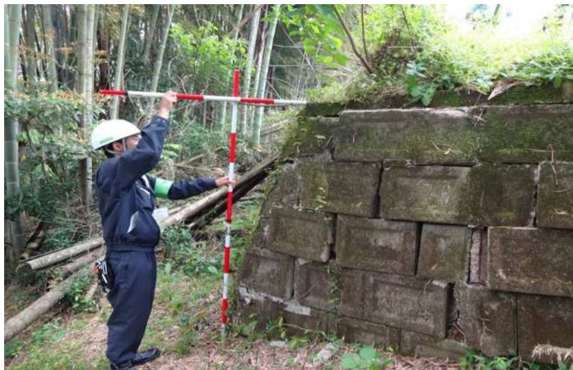
上部が崩壊した空石積み擁壁（危険判定）
