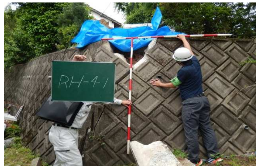
間知ブロック積み擁壁の崩壊（隅角部）
