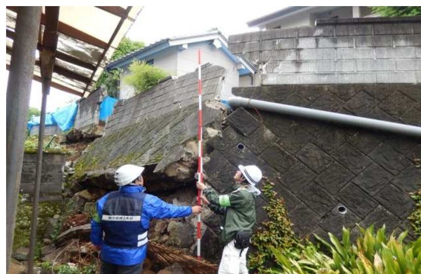
折損した間知石積み擁壁の高さ測定（危険判定）
