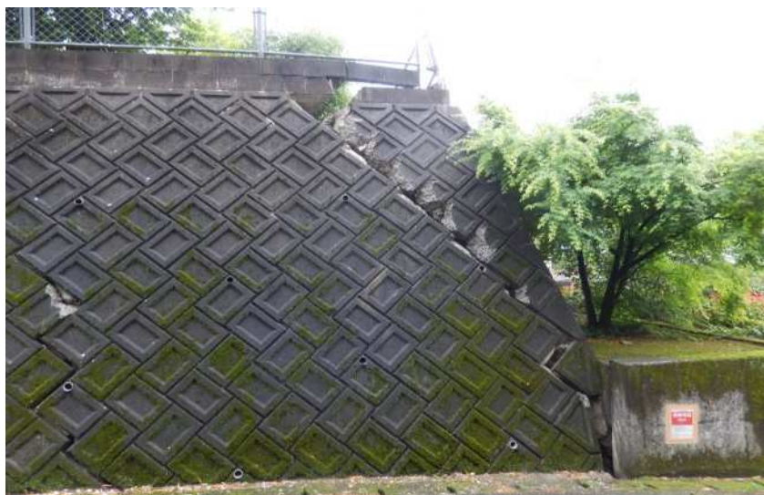
間知ブロック積み擁壁のクラック（隅角部）
