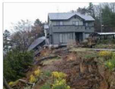
(東日本大震災:宮城県仙台市)
