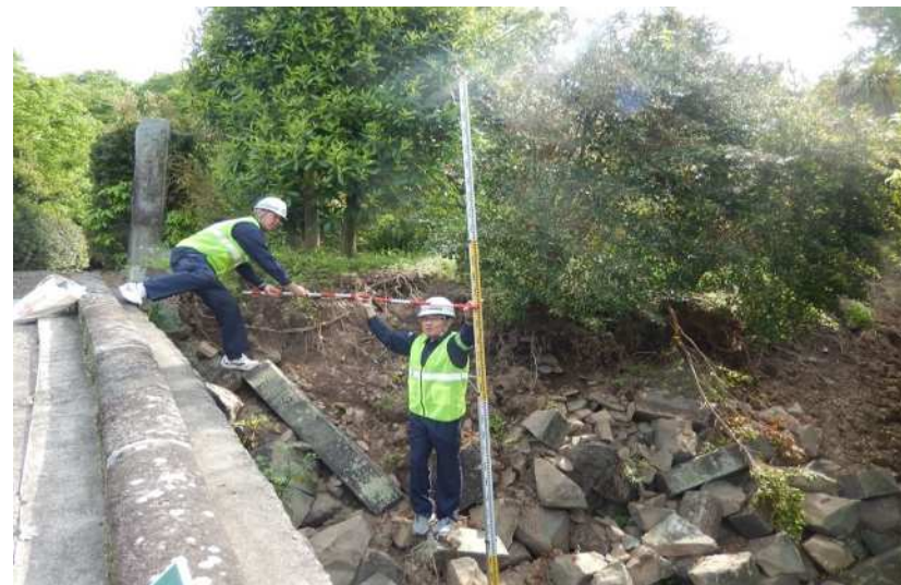
折損した間知石積み擁壁の高さ測定（危険判定）
