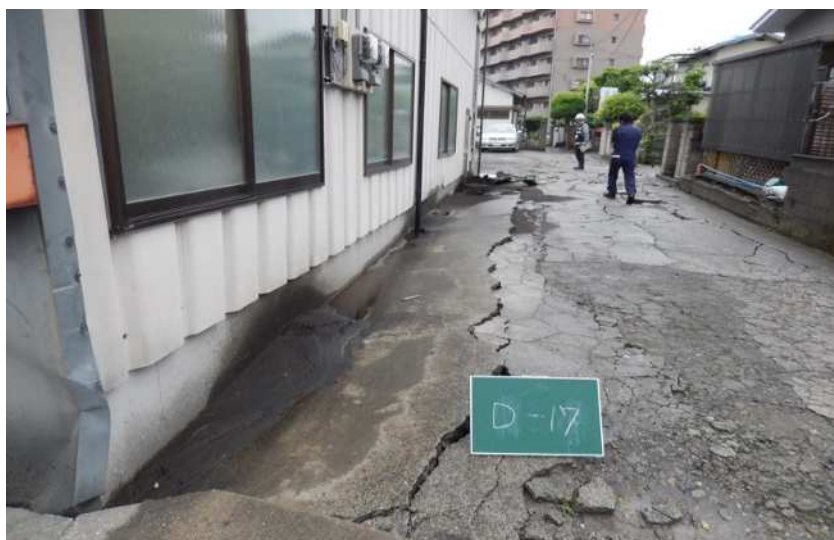
液状化により宅地地盤が沈下（噴砂）
