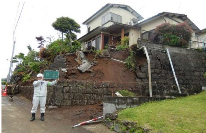
上部が崩壊した空石積み擁壁（危険判定）
