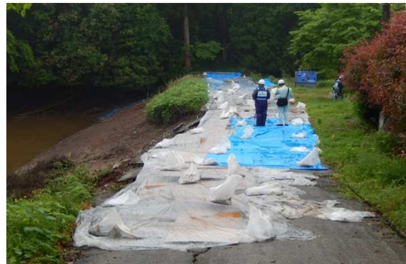
ため池の法面が滑落したクラック（要注意判定）
