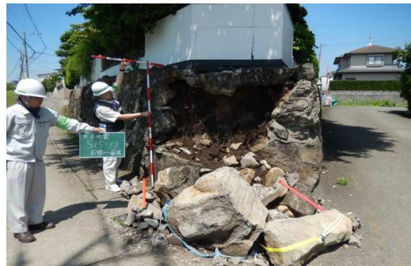
間知ブロック積み擁壁の崩壊（隅角部）
