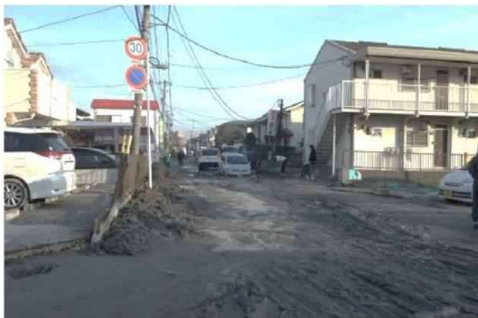
(a) 液状化の被害
