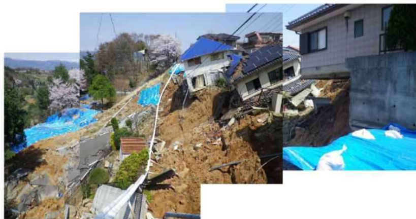
(d)液状化による側方流動の事例
