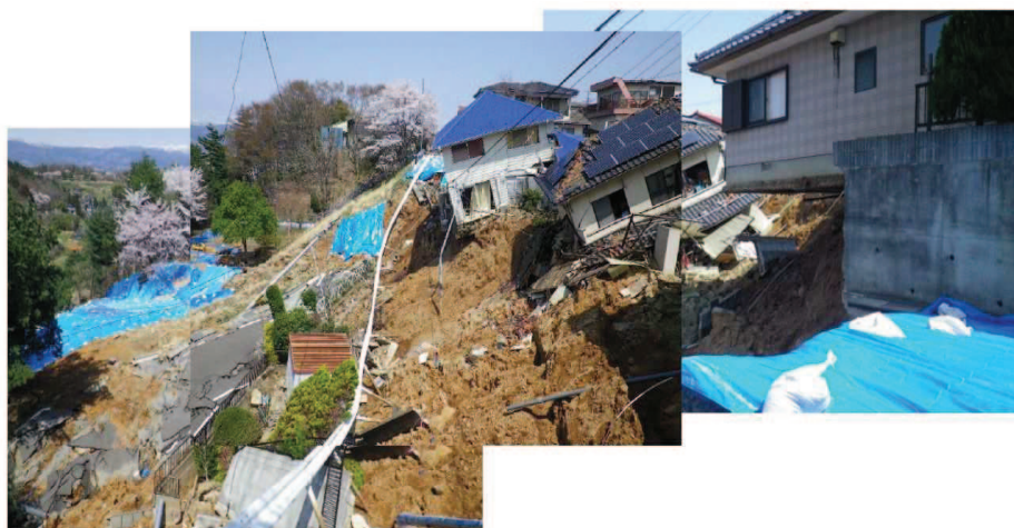
写 3－11 のり面の崩壊の例
