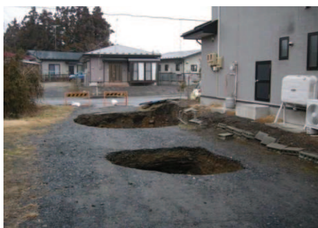
写 3-3 宅地地盤の陥没の例
