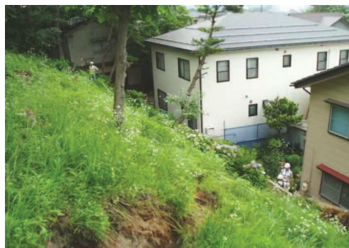
写3-8 のり面のクラックの例
