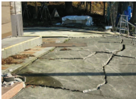
写３－２ 宅地地盤のクラックの例
