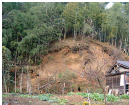
写 3-10 のり面のガリー浸食の例
