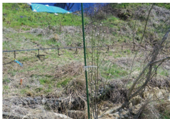
写 3-9 のり面のハラミ・盤ぶくれの例
