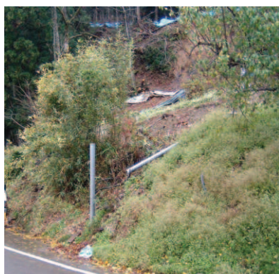
写 3-9 のり面のハラミ・盤ぶくれの例
