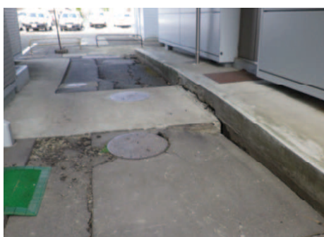
写 3-4 宅地地盤の沈下の例
