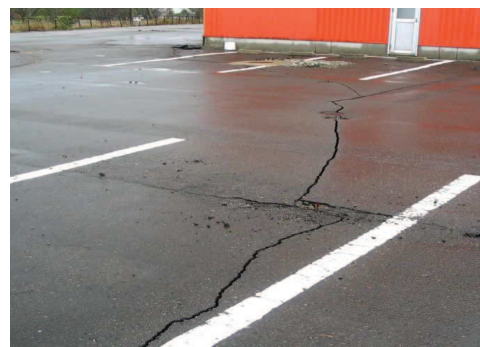
写３－２ 宅地地盤のクラックの例
