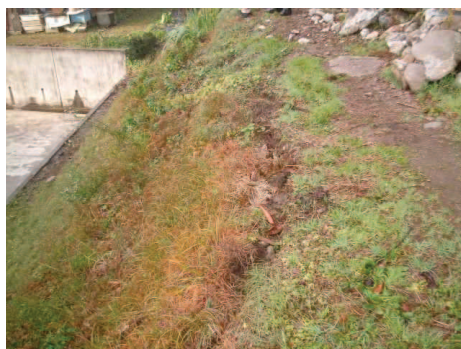
写3-8 のり面のクラックの例
