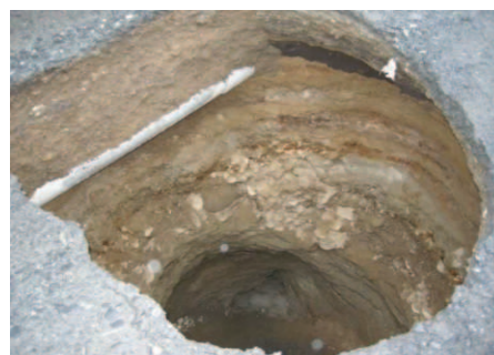
写 3-3 宅地地盤の陥没の例
