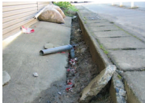
写 3-5 宅地地盤の段差の例
