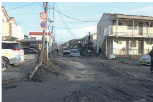
(a) 液状化の被害
