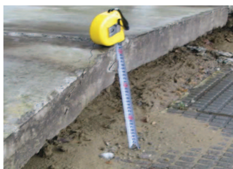
写 3-5 宅地地盤の段差の例
