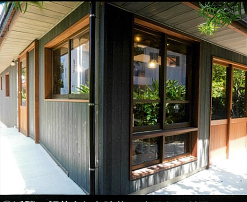
⑧近隣の解体された建物の建具を再利用
