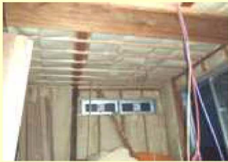
外壁断熱工事の例
