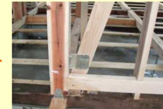
耐震補強工事の例
