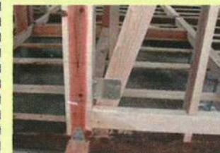
耐震補強工事の例
