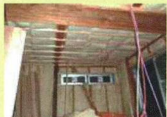
外壁断熱工事の例
