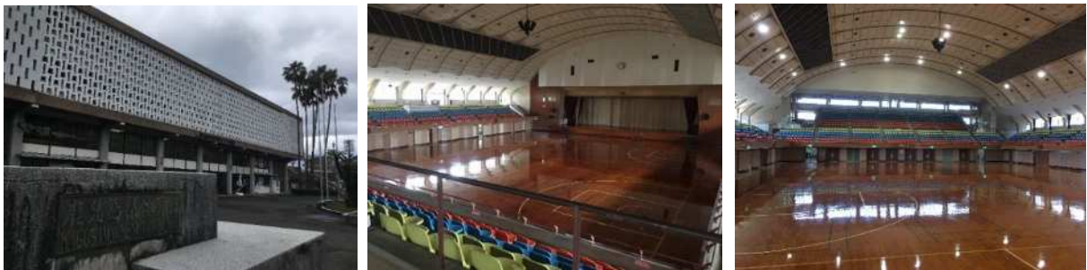
現体育館（1960 年 10 月竣工）
