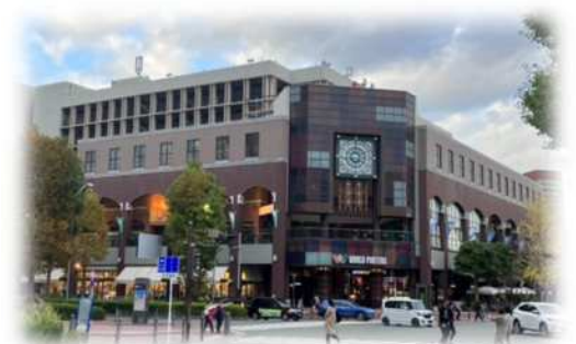
横浜ワールドポーターズ （立体駐車場）
