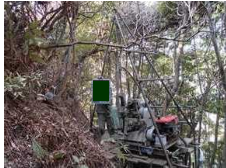
写真-1 機械ボーリング調査のイメージ
