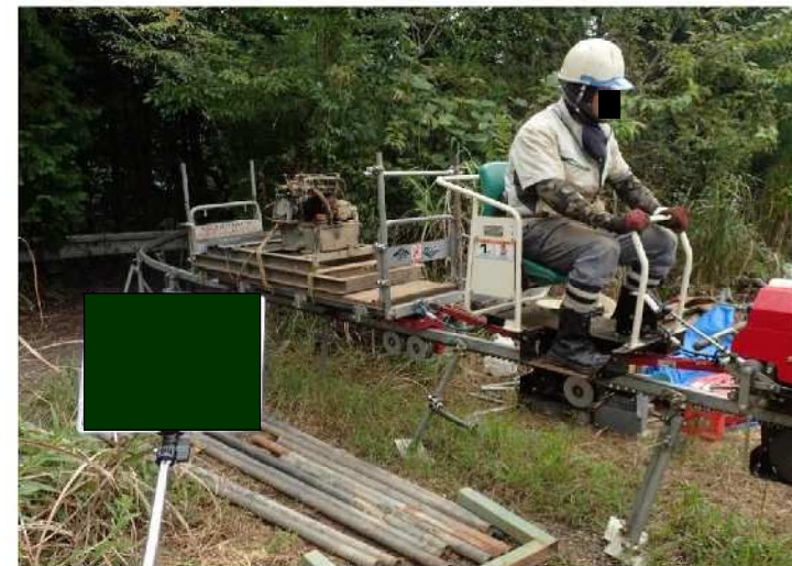
写真-2 モノレール仮設による資機材運搬のイメージ
