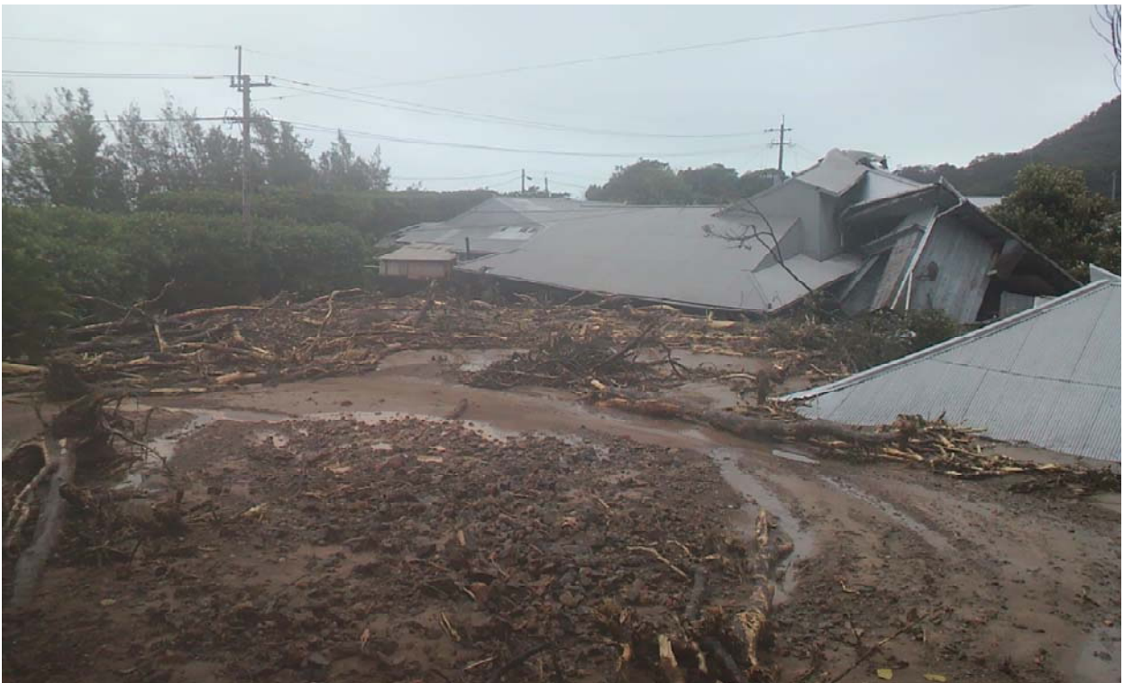
龍郷町赤尾木地区の被災状況
