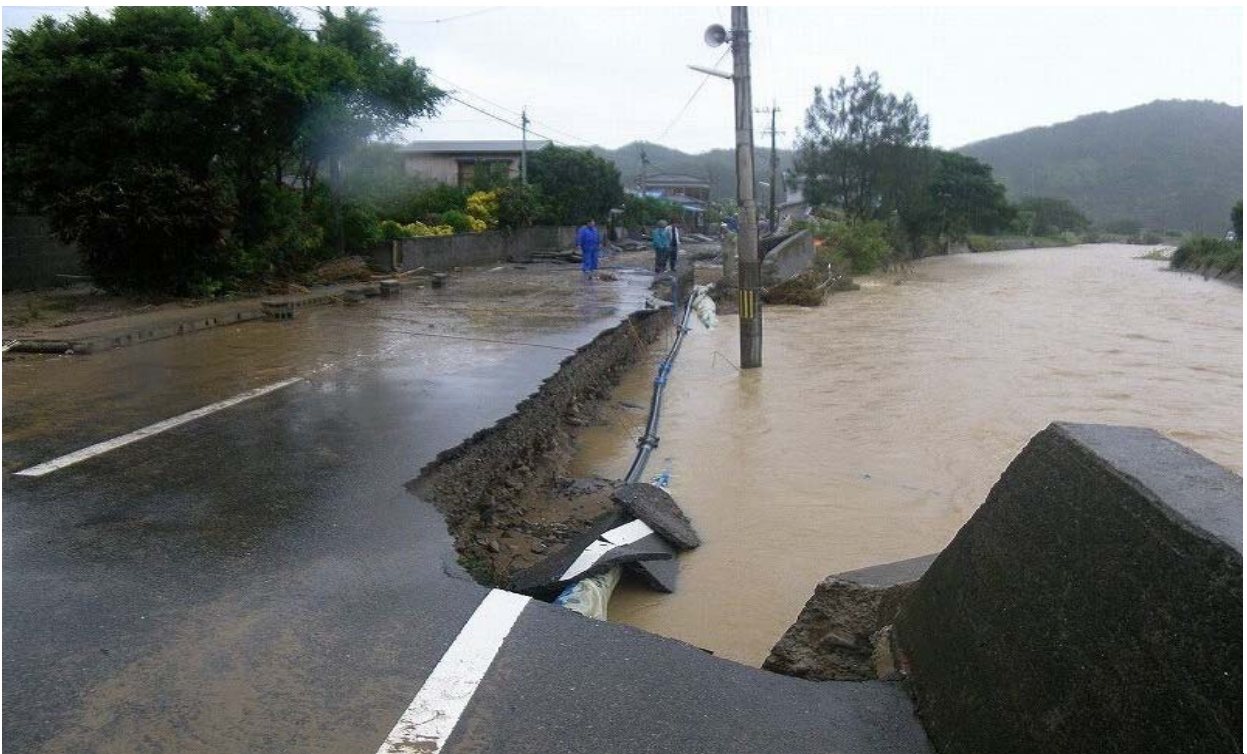
氾濫した戸口川の被災状況（龍郷町戸口地区）
