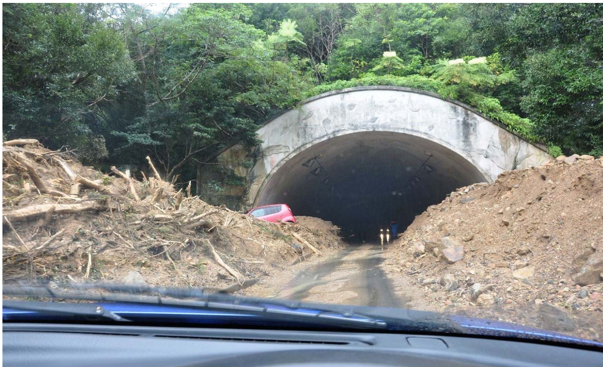
県道名瀬瀬戸内線（毛陣トンネル）の被災状況（大和村大和浜地区）
