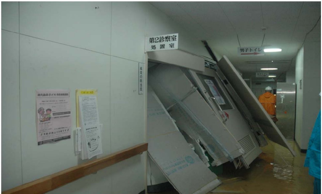
瀬戸内町へき地診療所の被災状況
