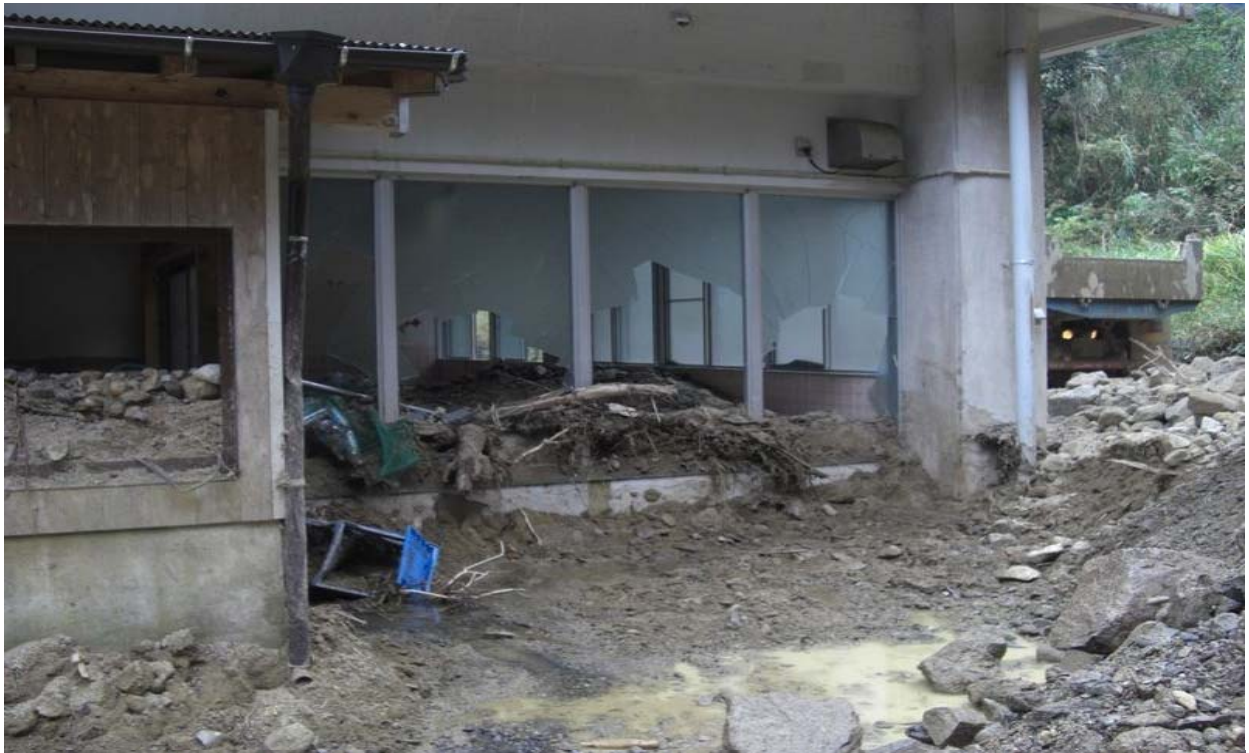
特別養護老人ホーム住用の園の被災状況（奄美市住用町）
