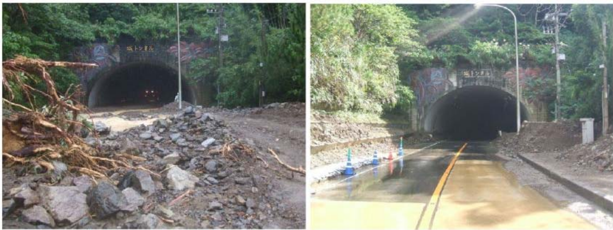
(社)建設業協会奄美支部による土砂除去状況(城トンネル)
