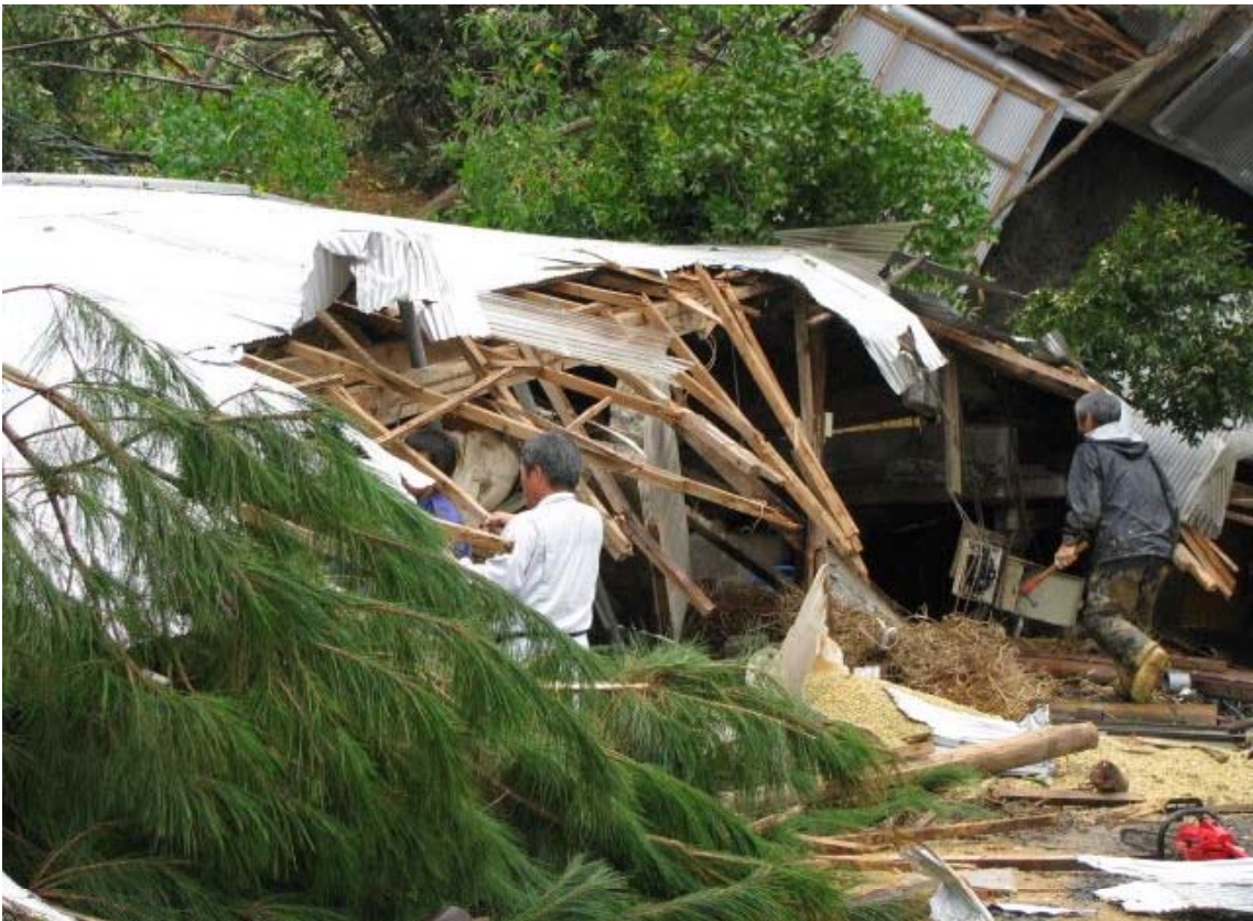
土砂流入により倒壊した畜舎（龍郷町）
