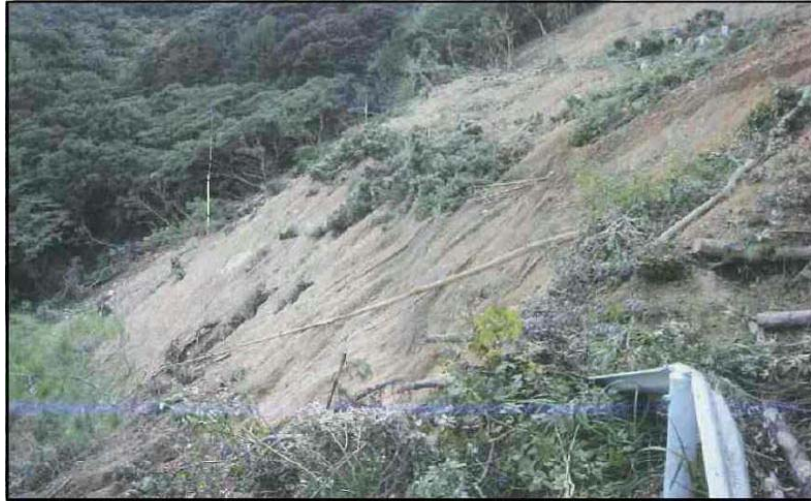
崩壊した法面【住用中央東線】(奄美市)
