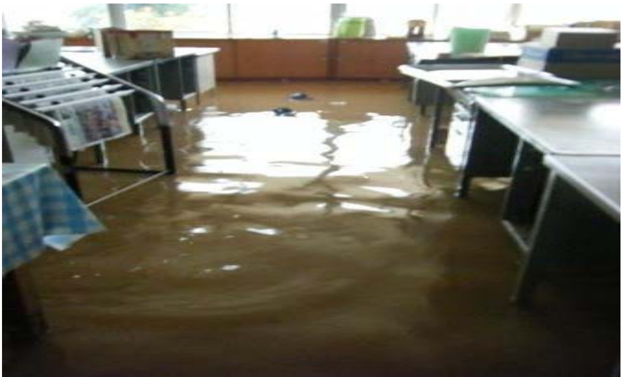
被災状況(東城小中学校 職員室)
