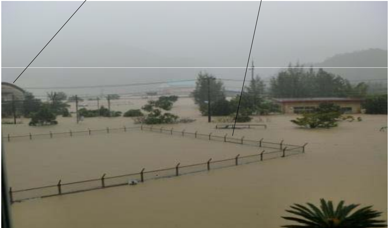
被災状況(東城小中学校 プール周辺)
