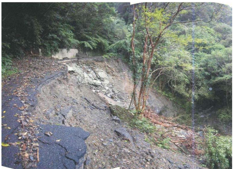
流出した路体【安念勝線】(奄美市)
