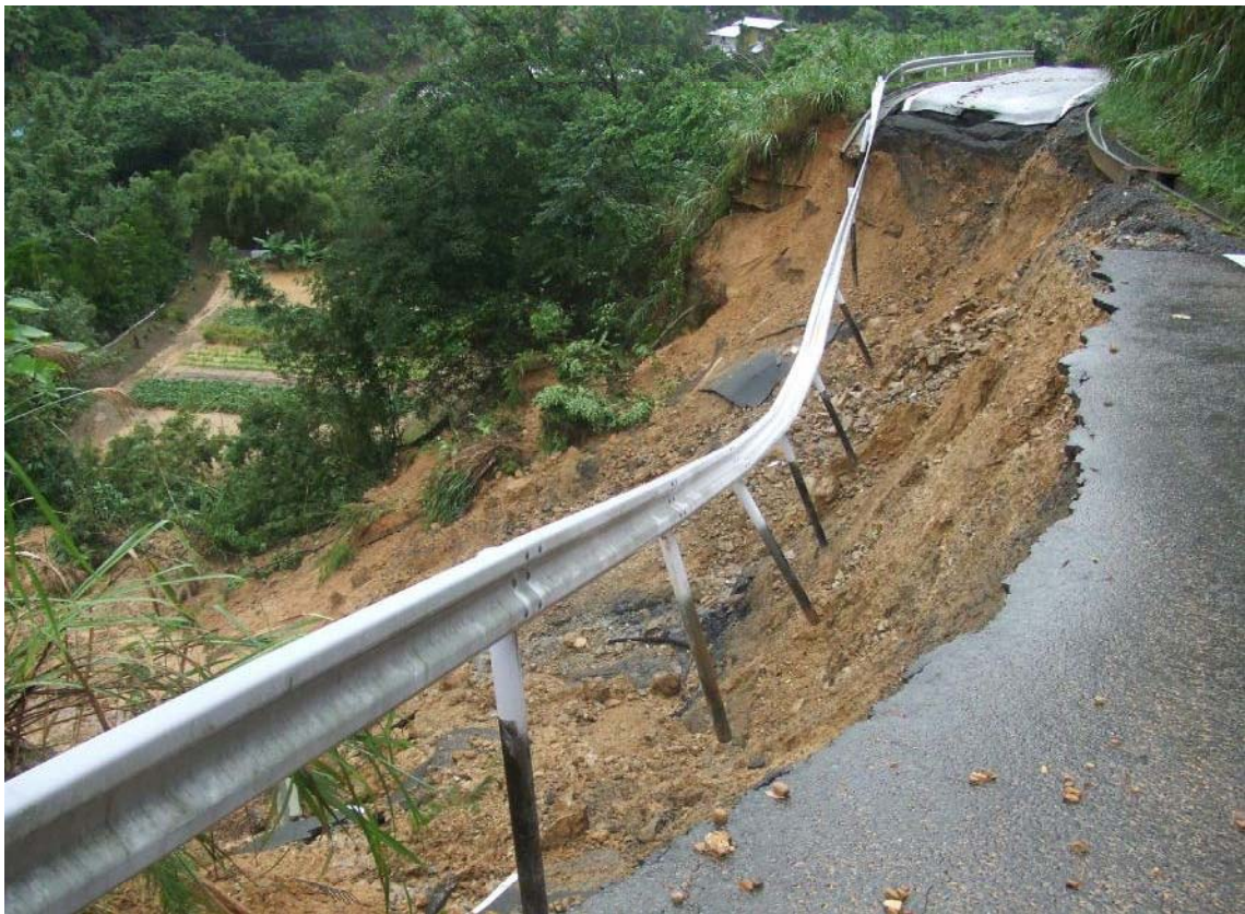
法面とともに崩壊し寸断された農道（奄美市名瀬）
