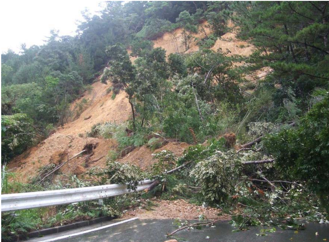
山腹の崩壊により埋没した農道（龍郷町）
