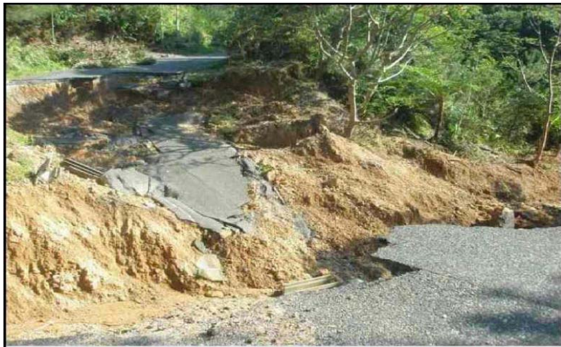
流出した路体【嘉徳青久線】(瀬戸内町)
