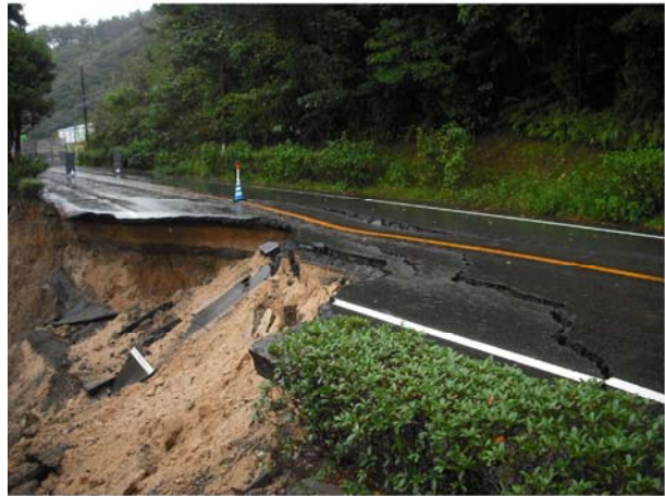
国道58号（奄美市名瀬浦上地内）
