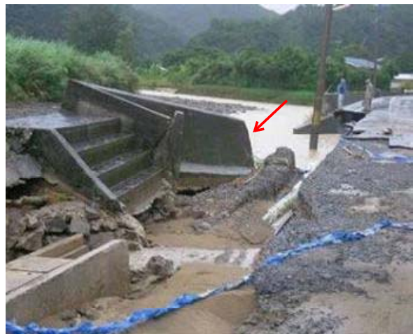
戸口川の破堤状況（龍郷町戸口）
