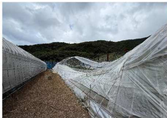
ビニルハウスの倒壊（大和村）
