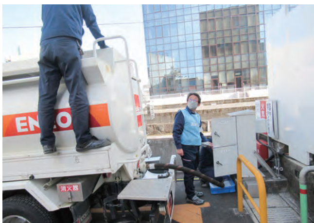
非常用発電機への燃料供給訓練
