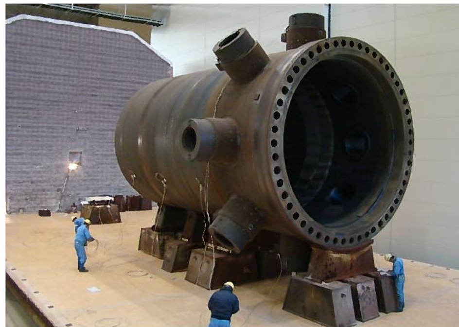
図3 熱処理炉台車へのRV設置の様子（4ループの例）
