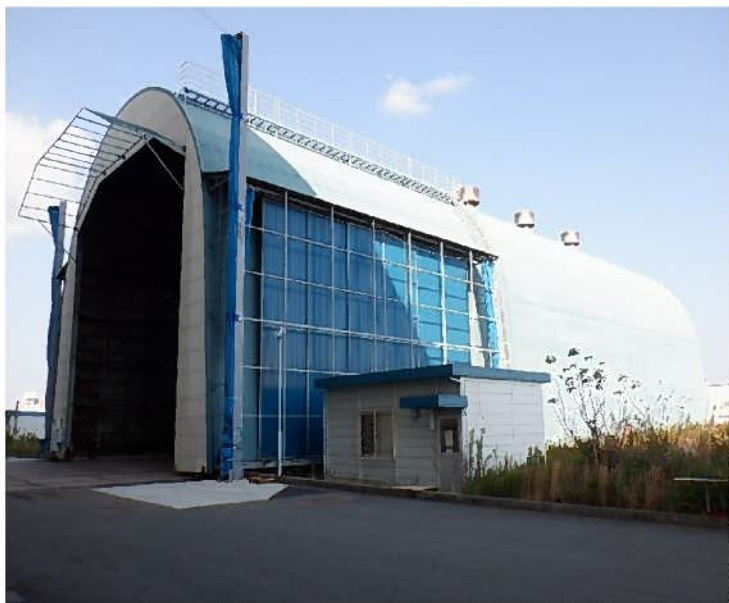
図2 大型熱処理炉外観
