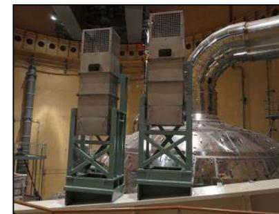
静的触媒式水素再結合装置
