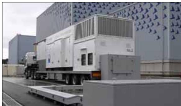
大容量空冷式発電機の起動状態確認
