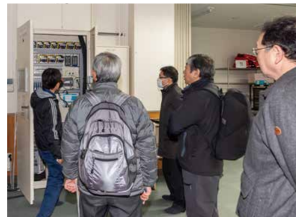
消防学校での代替オフサイトセンター立ち上げ訓練視察(日置市)
