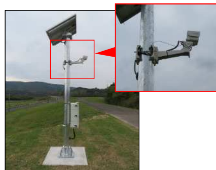
簡易型河川監視カメラ
