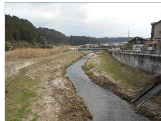
■整備状況（河川改修後）
