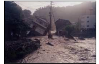
浸水被害(平成5年8月6日)
